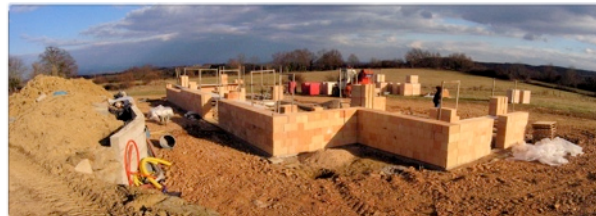
construction en cours, 6 avril 2006
